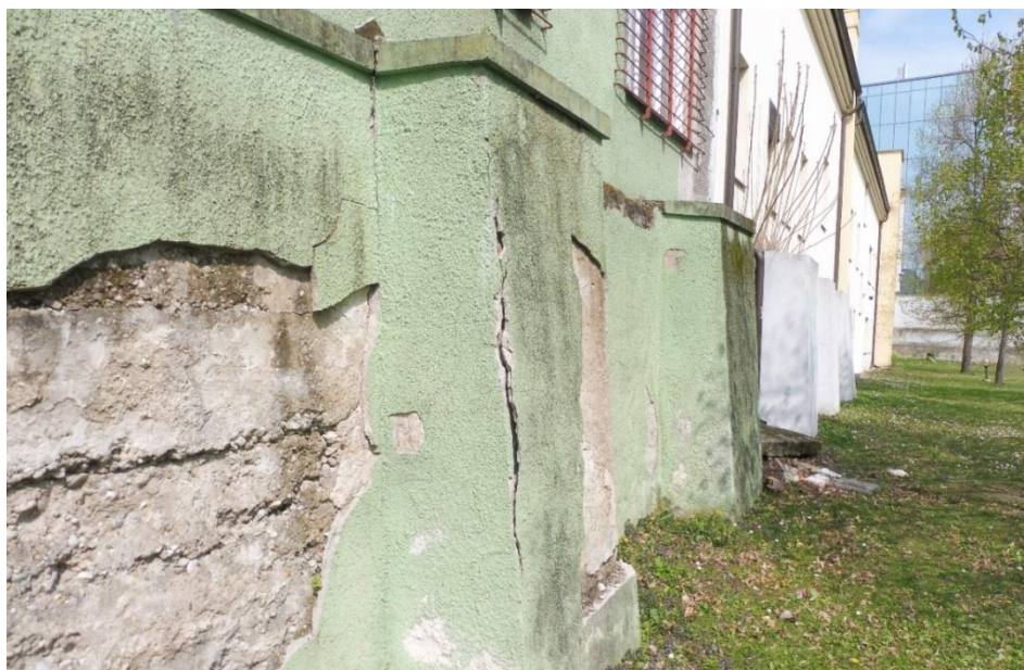
Pohľad na časť oporného múra stavby ÚV plynule prechádzajúci do prestavanej zadnej časti prezidentskej časti paláca
