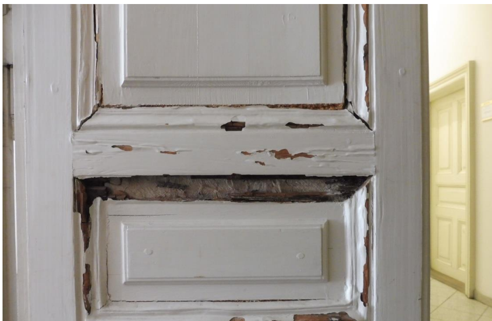
Neopraviteľné vady zosušeneho materiálu dverí a vyhnilé drevo
