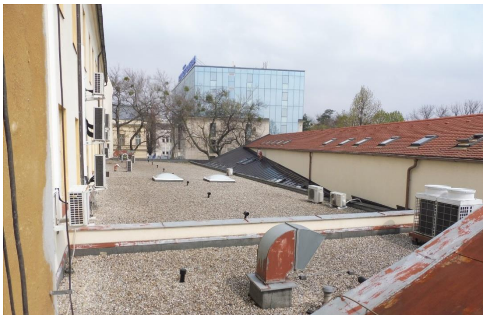
Opravená strecha a druhé a tretie nadzemné podlažie s novými oknami (eurookná)
