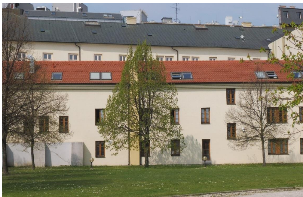
Pohľad na dostavbu prezidentskej časti paláca z prezidentskej záhrady s novou strechou a oknami
