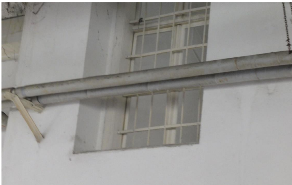
Okno pod plechovou strechou prístavby prekrížené teplovodom na vonkajšej časti fasády privádzajúce teplo z prezidentskej časti paláca, kde je umiestnená spoločná kotolňa
