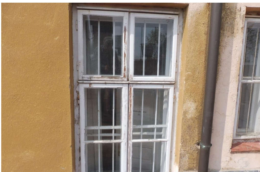
Necitlivo zakomponované a dodatočne osadené mreže do všetkých okien v zadnom trakte
