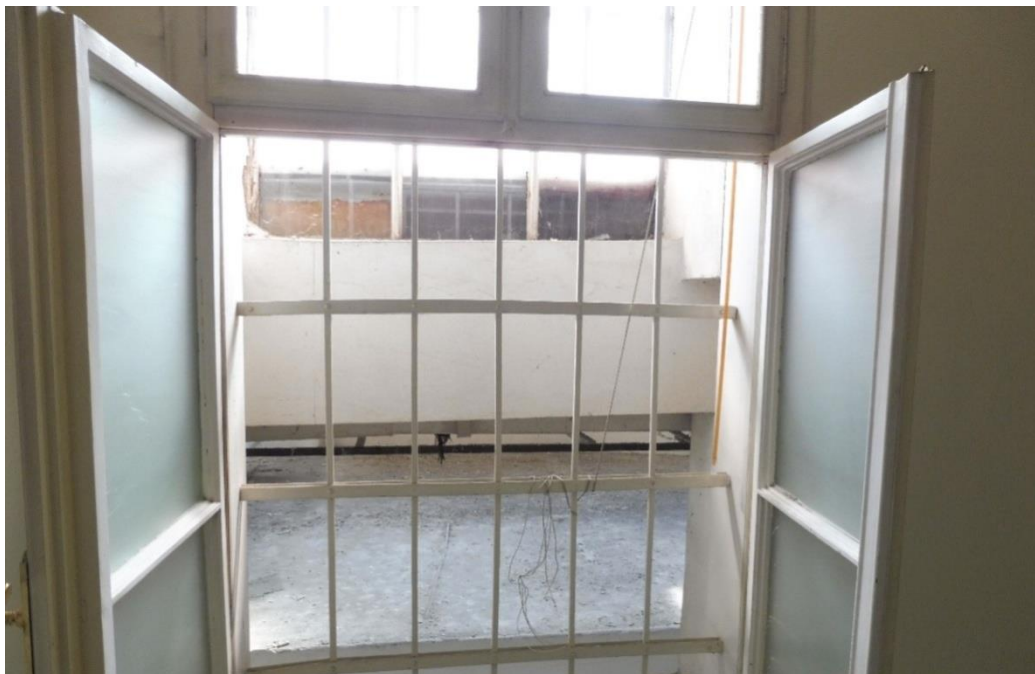
Pohľad z okna na okno rozdelené betónovým prekladom strechy na polovicu (jedna nad strechou a jedna pod strechou) s vloženou železnou mrežou
